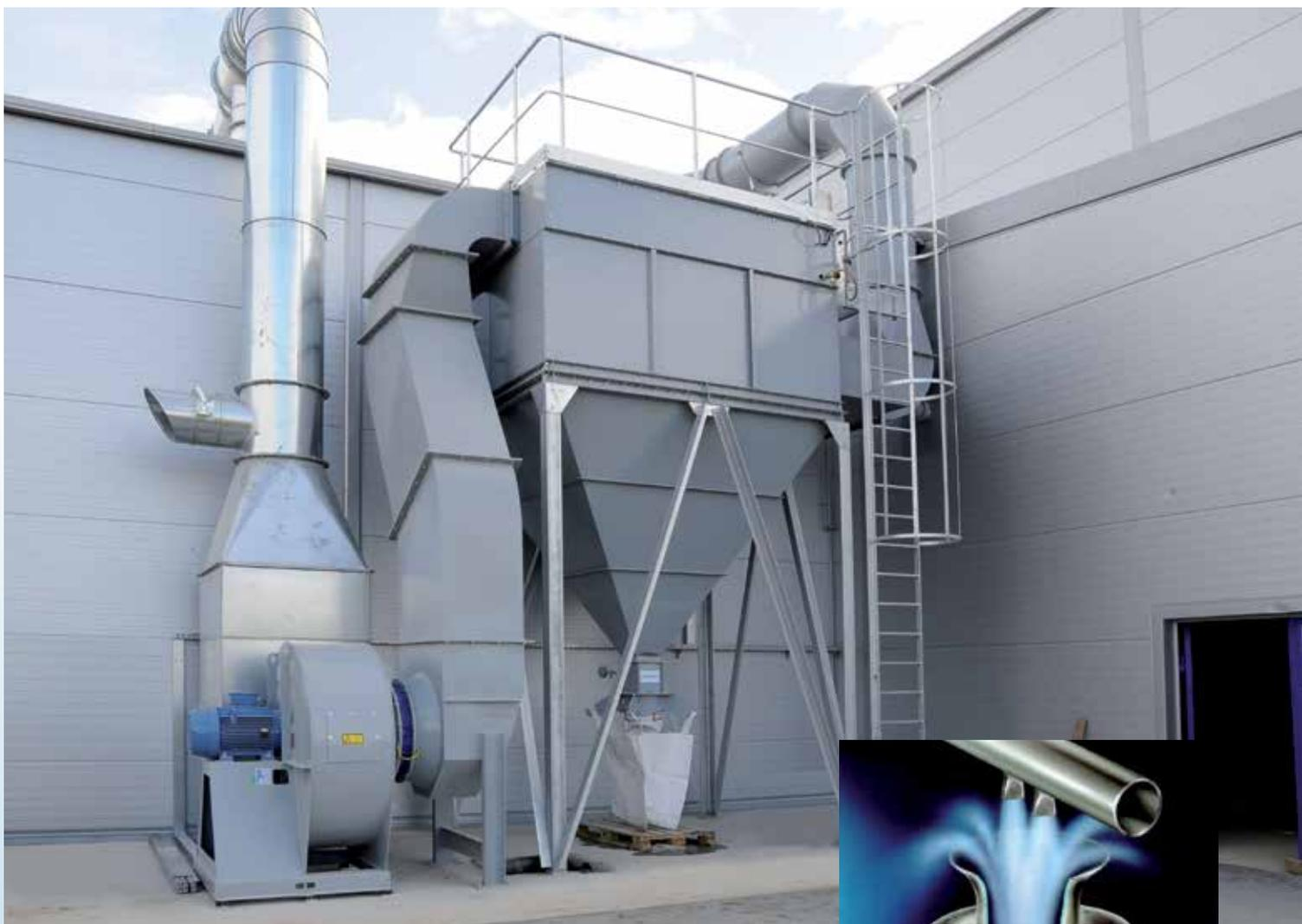
**Jet Patronenfilter 20.000 m<sup>3</sup>/h mit Big Bag Absackung, Schalldämpfer und Radialventilator**
